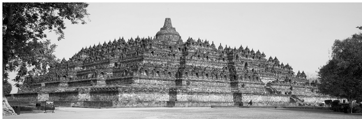
図2 ボロブドゥール（北西）
